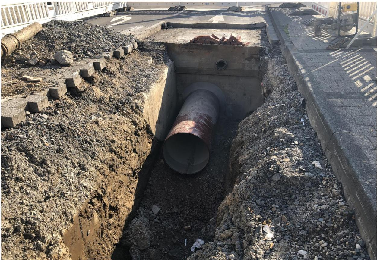
Abb. 2: Starkregentlastungskanal; duktiles Gussrohr DN 800
