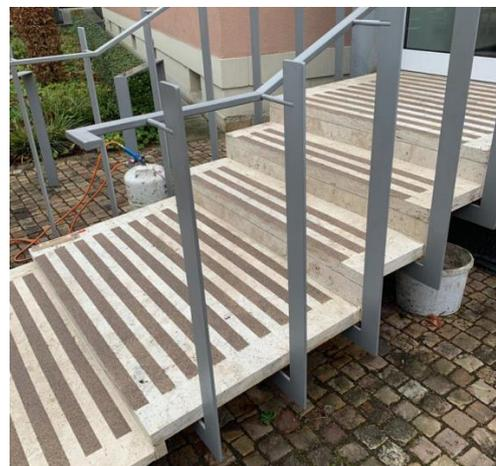
4. Treppenstufen mit vorgefertigter Kontrastkante
