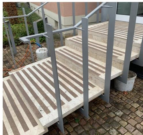
4. Treppenstufen mit vorgefertigter Kontrastkante
