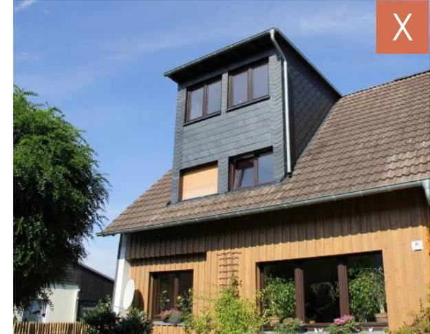
Abbildung 43: Überdimensionierte Dachgaube.
