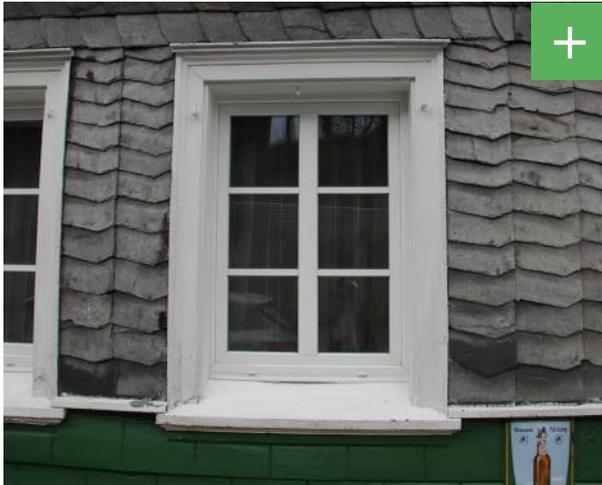
Abbildung 67: Pfostenprossenfenster als Gestaltungselement der Fassade.
