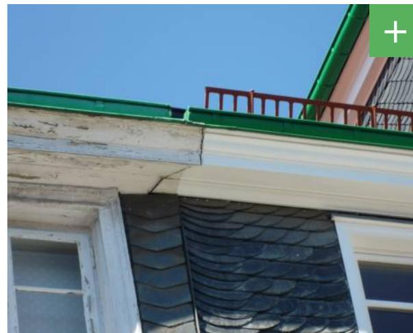
Abbildung 25: Durchlaufender Traufkasten bei zwei Gebäuden.
