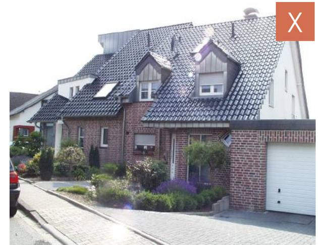
Abbildung 34: Störende Reflexionen durch glasierte Dacheindeckung.
