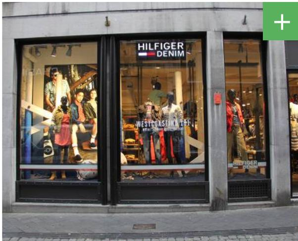
Abbildung 75: Schaufensterunterteilung durch Mauerpfeiler und Rahmenelemente.
