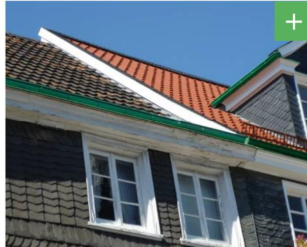
Abbildung 24: Beispiel für eine gelungene Aufdachdämmung (Farbton hiernicht angepasst).
