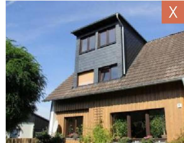
Abbildung 43: Überdimensionierte Dachgaube.
