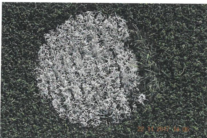
Foto Nr. 5: Beschädigter Strafstoßpunkt; es hat den Anschein, dass hier lediglich der Strafstoßpunkt und nicht die Umgebungsfläche ausgetauscht wurde.
