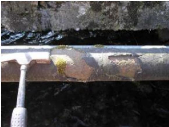
Verrostetes Schutzrohr am Überbau
