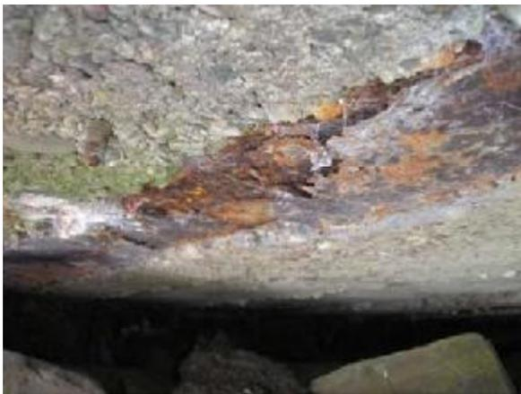
Stark verrostete Stahlträger (im Beton)
